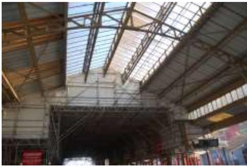
La Grande Halle aux voyageurs de 110 mètres de long et de 19 mètres de large couvrant les 2 voies va être rénovée. Le vitrage d'origine va être remplacé par des plaques de polycarbonate, les descentes d'eau vont être changées et la peinture refaite.
